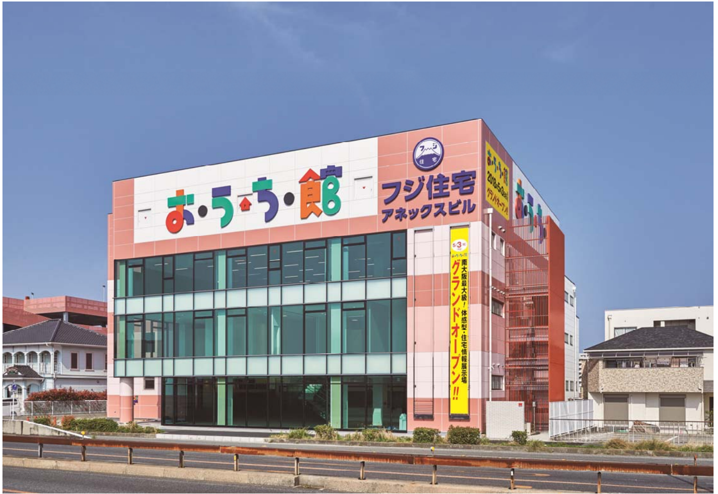
【本社アネックスビル おうち館本店 外観】
