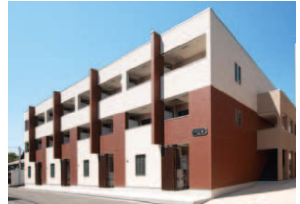
スリーハーブズ (全戸メゾネット型賃貸住宅)
