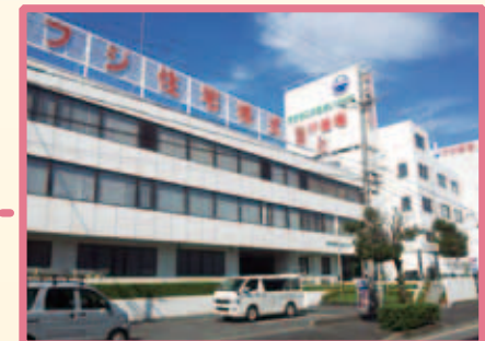
フジ住宅本社
