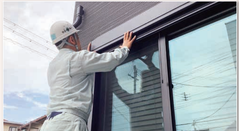
アフター補修
