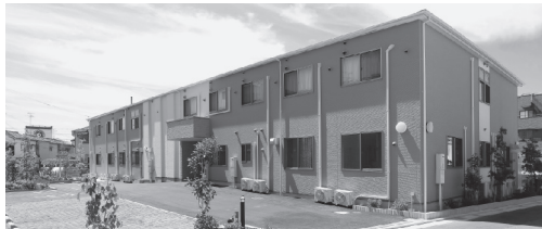
サービス付き高齢者向け住宅「フジパレスシア」
